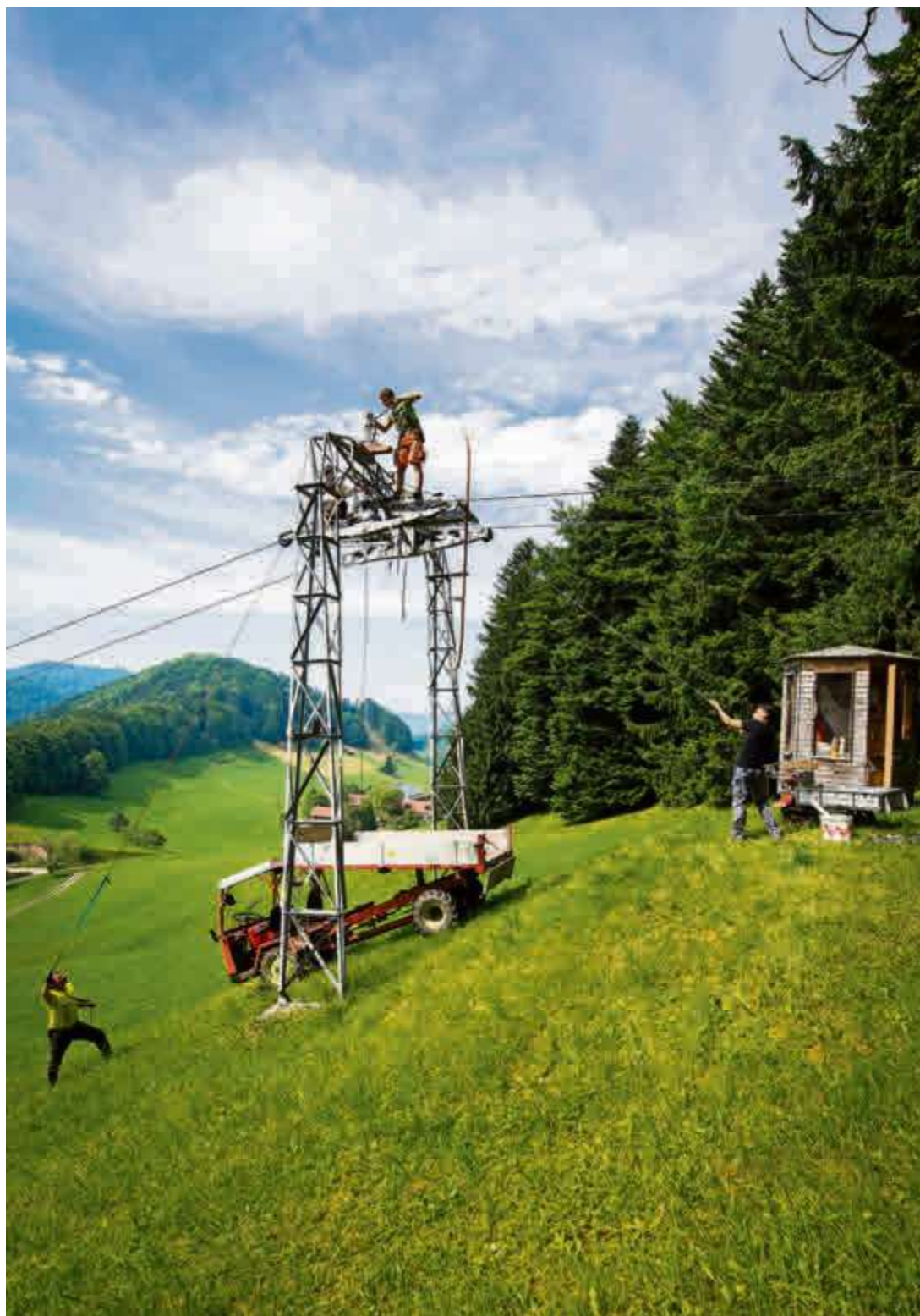
Aufwendige Arbeit am Skilift Steig in Bäretswil: Die Rollenbatterien auf den Masten müssen revidiert werden. Jedes Jahr ist nun einer der Masten an der Reihe.
